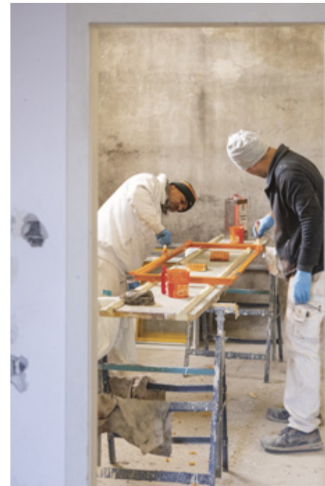
Insgesamt 250 Fensterflügel wurden gereinigt und neu gestrichen
