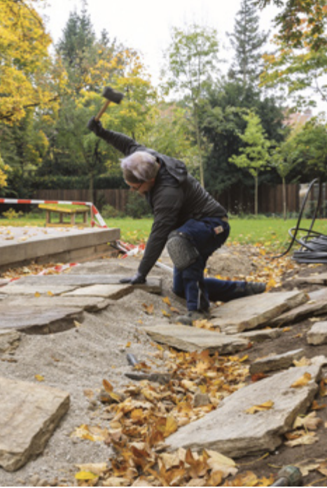
Wiederherstellung der Gartenwege aus den originalen Platten
