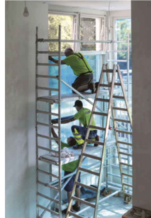
Anbringung der Folien zum Schutz der neuen Fensterscheiben
