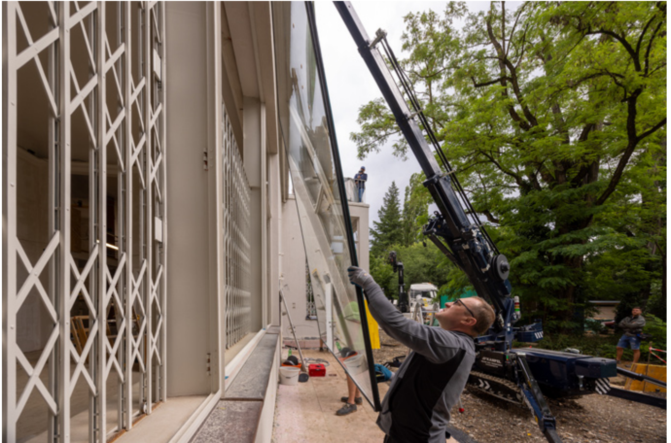
Einbau der großen Isolierglasscheibe im Speisezimmer
