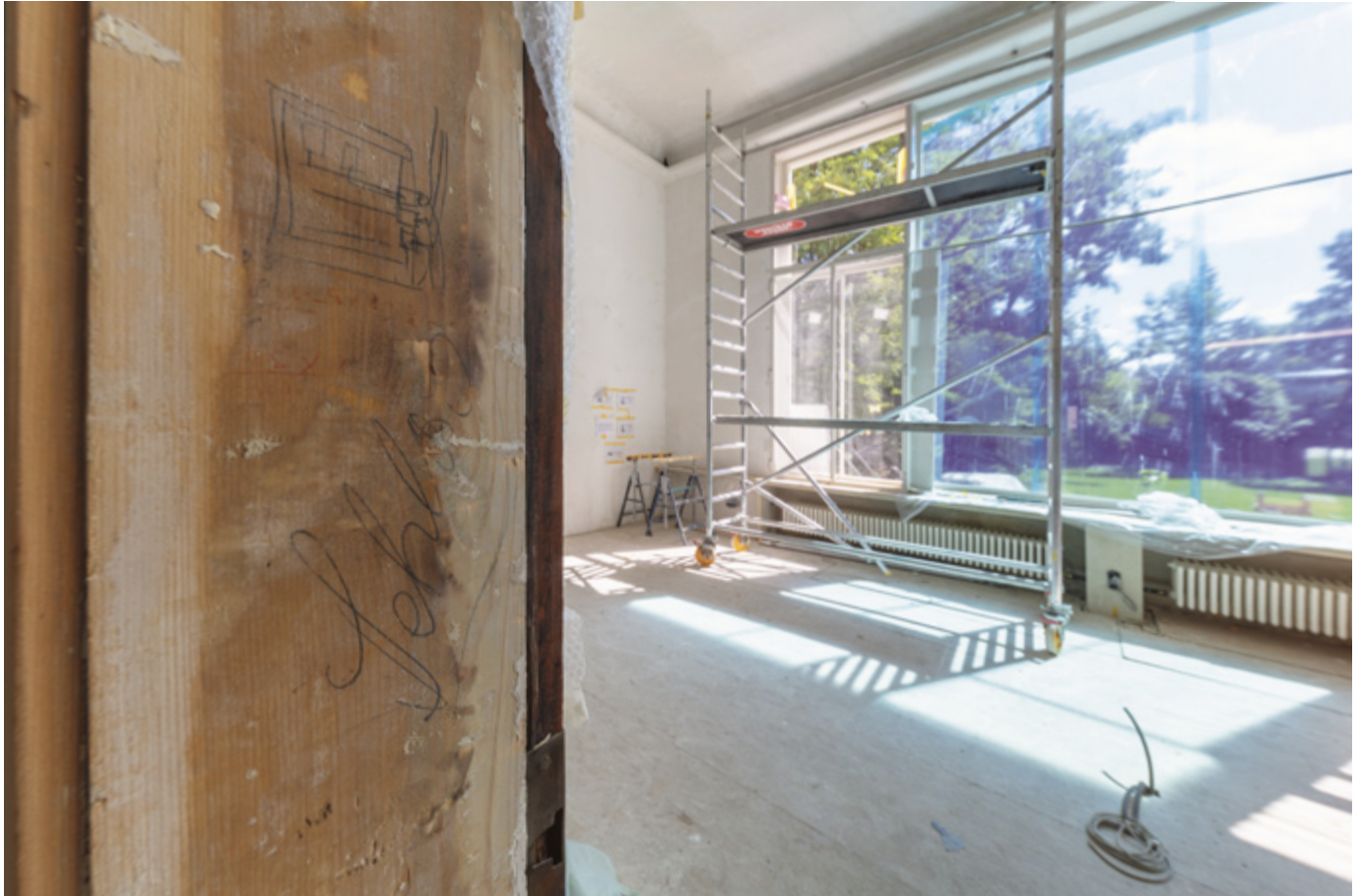
Beschriftungen und Elektro-Schaltplan aus der Bauzeit am Türrstock zum Speisezimmer
