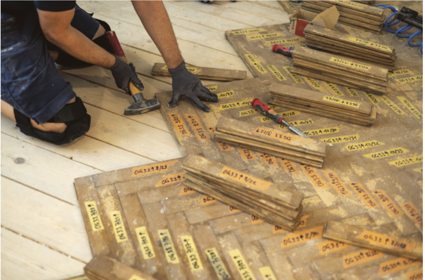
Über 5000 Parkettstäbe wurden ausgebaut und nach Sanierung des Unterbodens wieder originalgetreu verlegt
