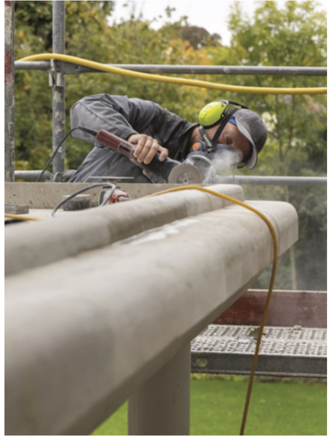
Wiederherstellung der Kunststeineinfassung der Terrassen
