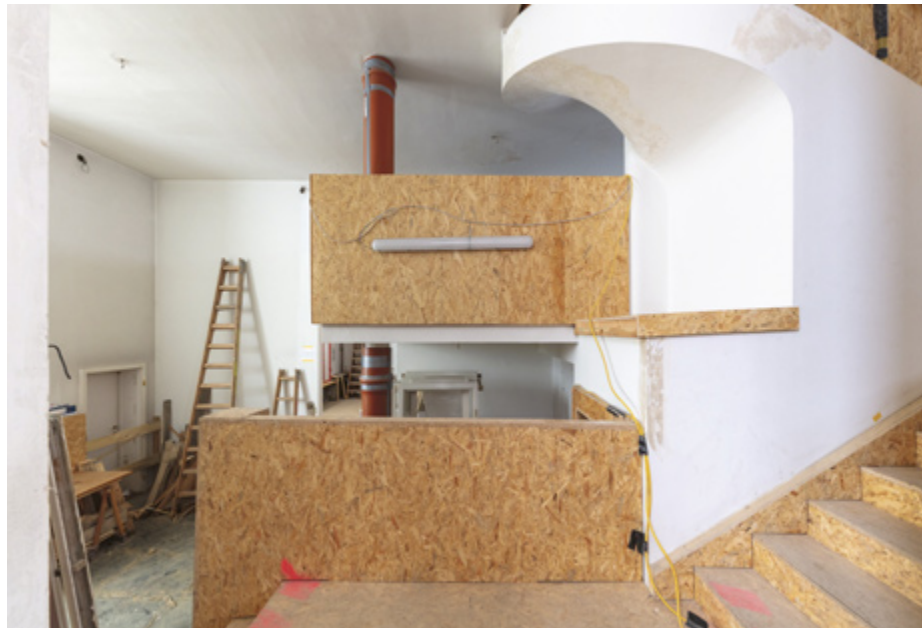
Maßnahmen zum Schutz der Substanz während der Arbeiten im Inneren
