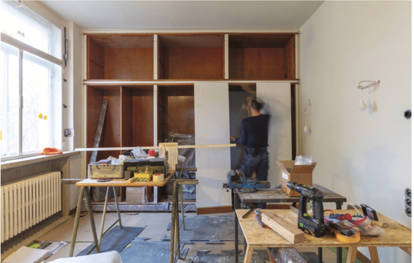
Die 16 Einbauschränke wurden teils vor Ort, teils außer Haus restauriert, fehlende Teile wurden ergänzt
